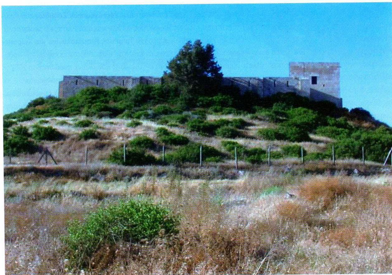
Εξωτερική (νότια) όψη αγρέπαυλης Κουκλιών.
